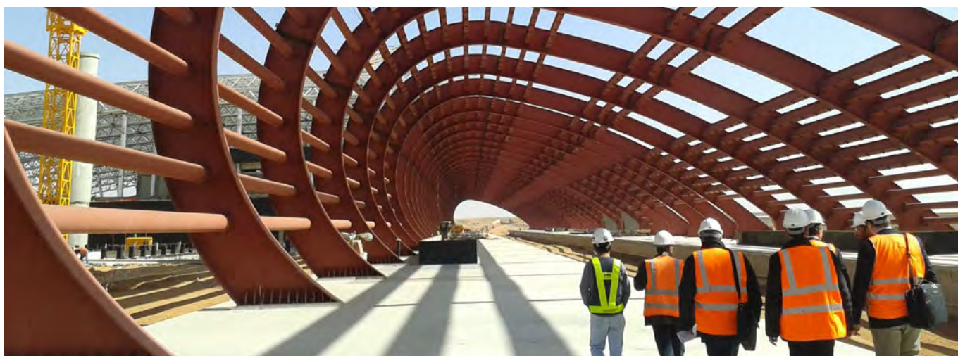
Costruzione di una stazione ferroviaria in Arabia Saudita
