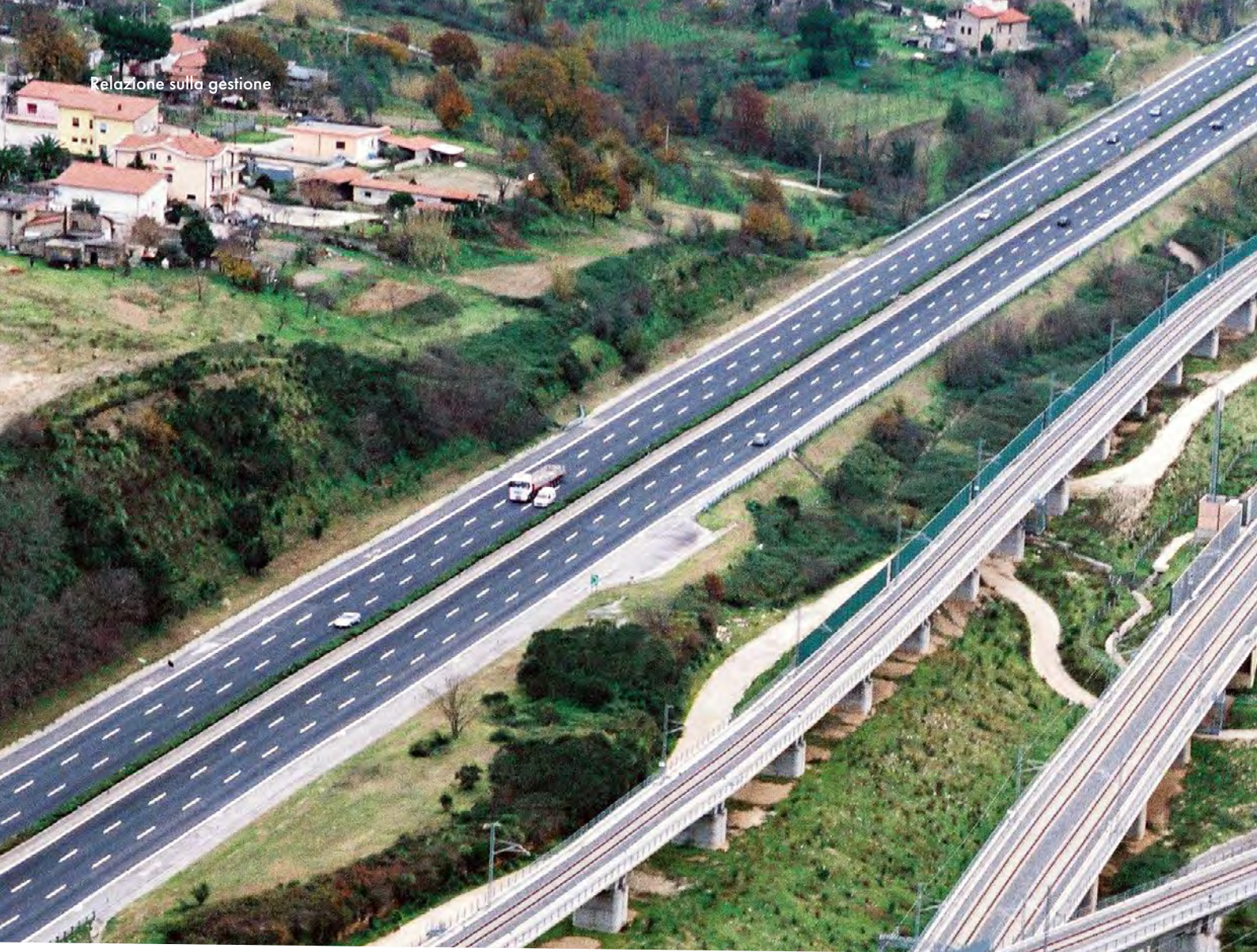
Infrastruttura ferroviaria e stradale
