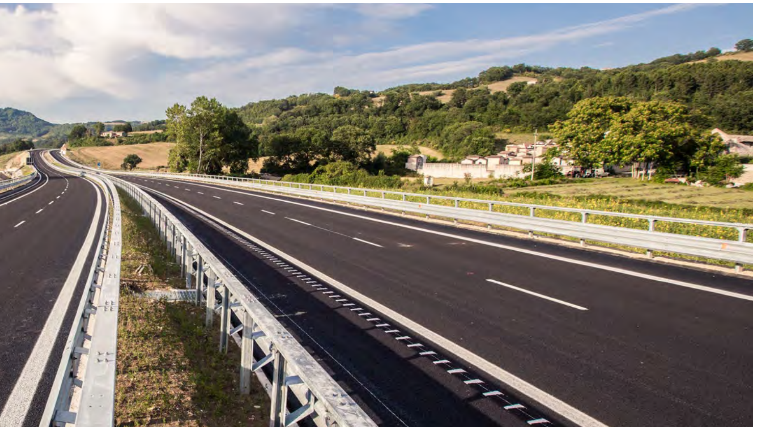
Infrastruttura stradale, Anas
