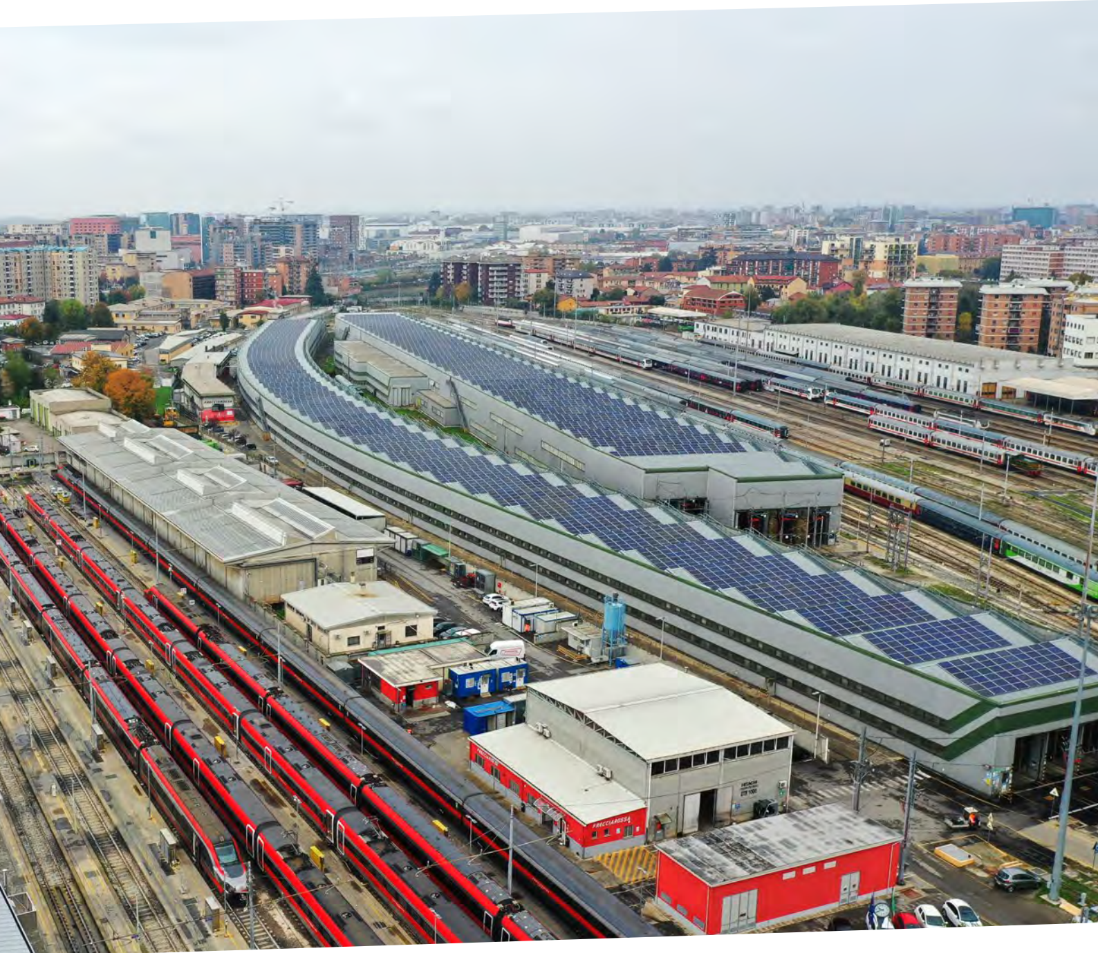
Impianto di Milano Martesana
