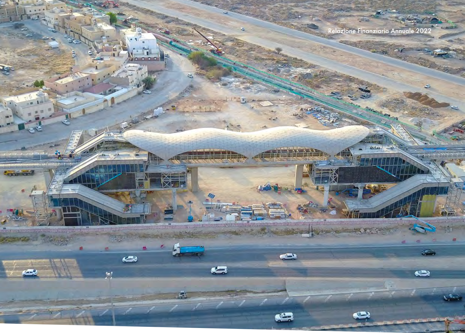
Costruzione della linea 3, Metro Riyad
