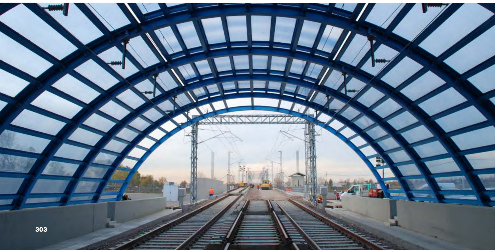
Galleria di Fontanellato, Italferr
