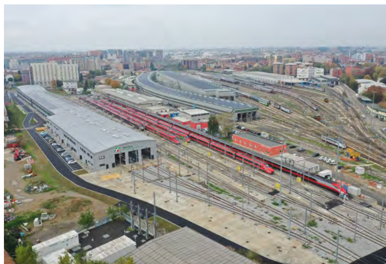
Impianto di Milano Martesana
