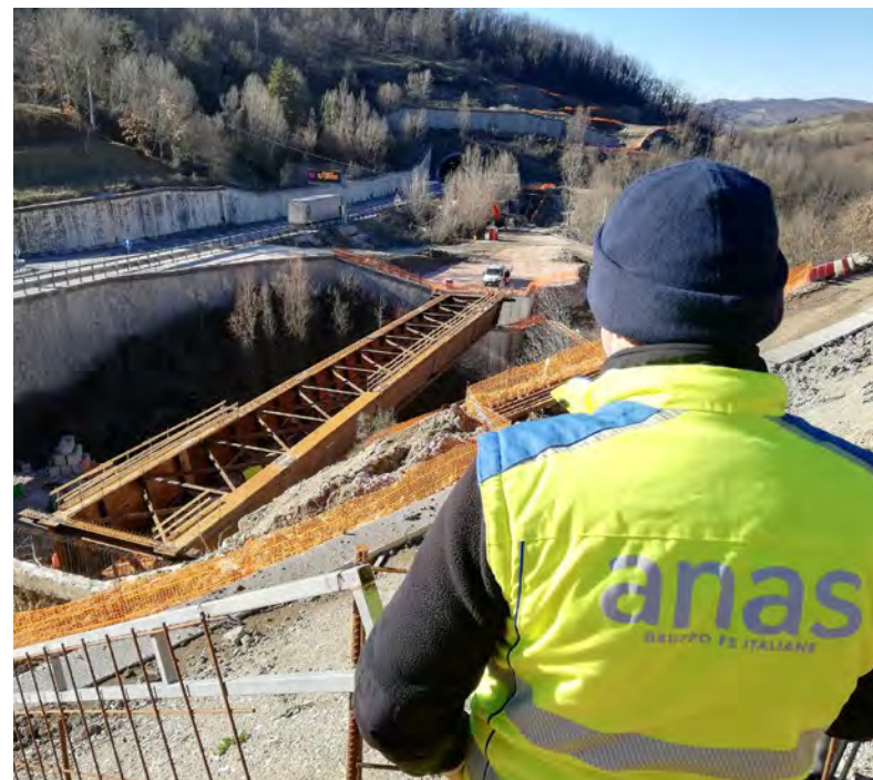
Cantiere stradale, Anas
